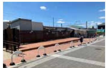
↑だれも使わないのもったいないくらい、しっかりとしたウッドデッキ
